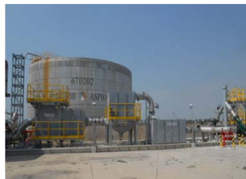
รูปที่ 3-5 ระบบควบคุมไอระเหยจากท่อระบาย ของถังเก็บกักยางมะตอย
