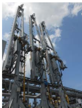
รูปที่ 3-4 แขนขนถ่ายวัตถุดิบและผลิตภัณฑ์ (Loading Arm)
