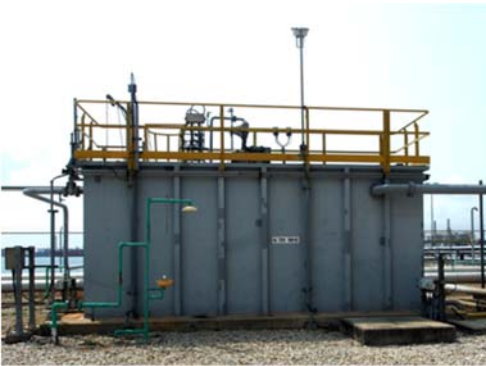
รูปที่ 3-8 ระบบบำบัดน้ำเสียภายในท่าเทียบเรือ (Sanitary Treatment System)
